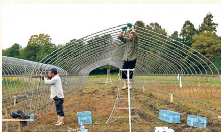
ハウスの設置作業など農家への支援が活動の軸。
